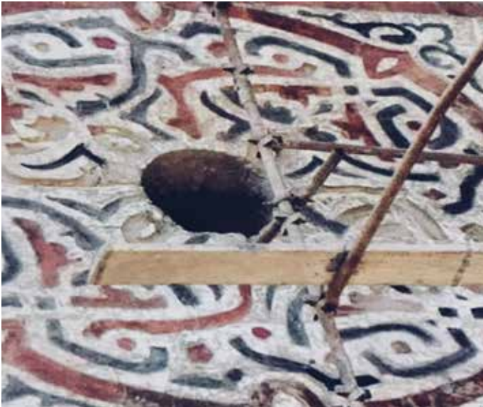
الزخارف على واجهة البيمارستان بعد أعمال التنظيف والترميم
