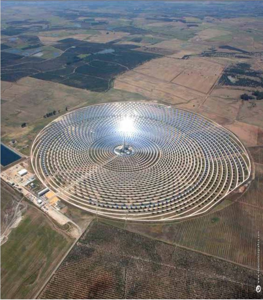
محطة كهرباء شمسية حرارية في إسبانيا بها قدرة تخزين 15 ساعة لإنتاج الكهرباء بعد غروب الشمس. ويرى بوضوح البرج الذي يحمل البؤرة في الوسط وحوله صفوف المرايا في دوائر وهذه تعكس أشعة الشمس على البؤرة
