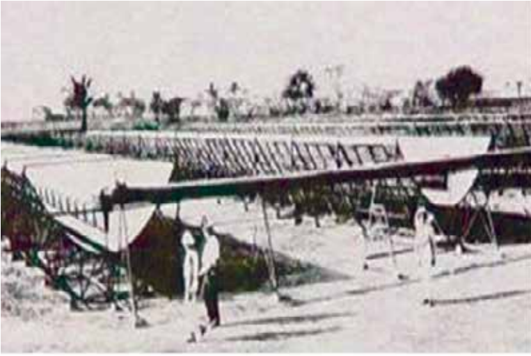
صورتان تبينان مرايا تركيز أشعة الشمس التي أنشئت في المعادى 1912 وبدأ عملها الفعلى 1913
