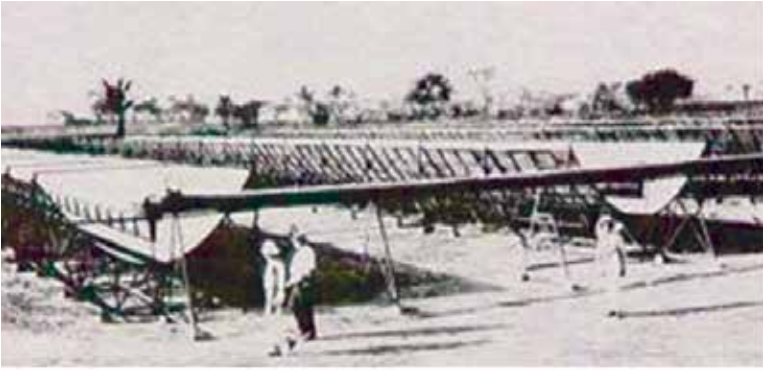
صورتان تبينان مرايا تركيز أشعة الشمس التي أنشئت في المعادي 1912 وبدأ عملها الفعلي 1913
