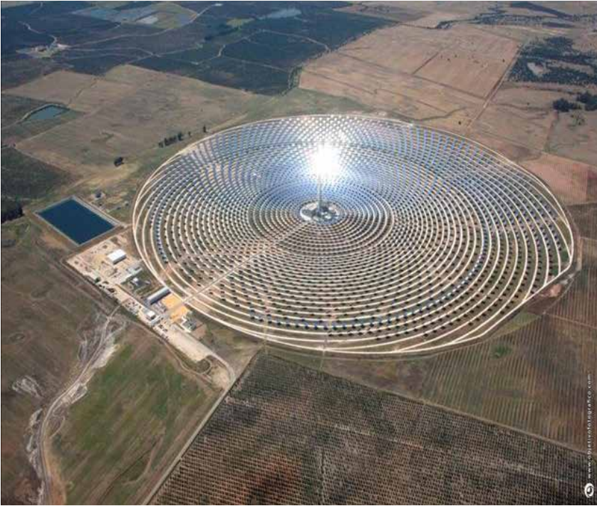
محطة كهرباء شمسية حرارية في إسبانيا بها قدرة تخزين 15 ساعة لإنتاج الكهرباء بعد غروب الشمس. ويرى بوضوح البرج الذي يحمل البؤرة في الوسط وحوله صفوف المرايا في دوائر وهذه تعكس أشعة الشمس على البؤرة.
